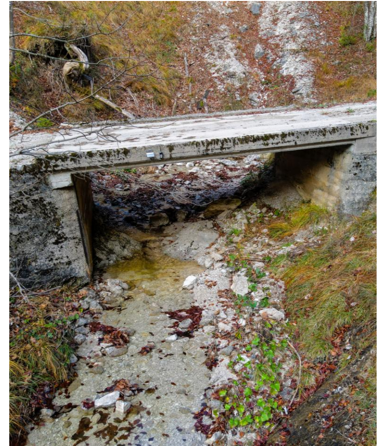
Abb. 1: montierter Abflusshöhensensor TEZG 4
