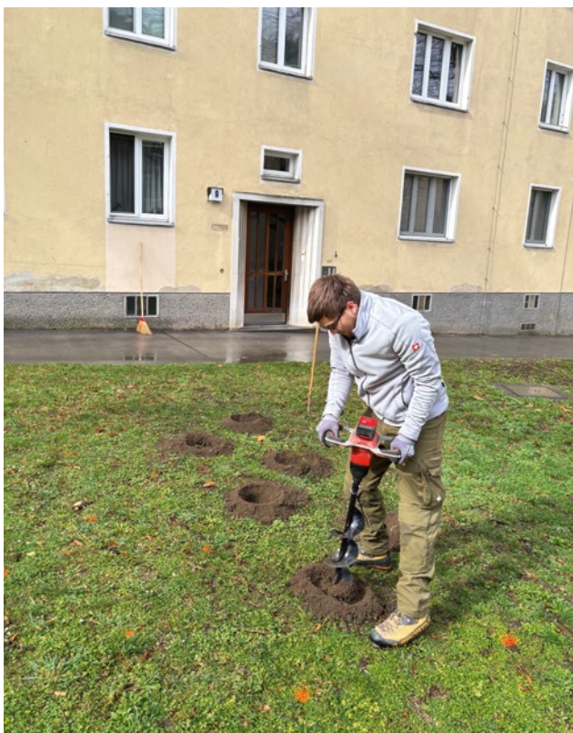
Vorbereitung der Pflanzlöcher mit einem Erdbohrer.
