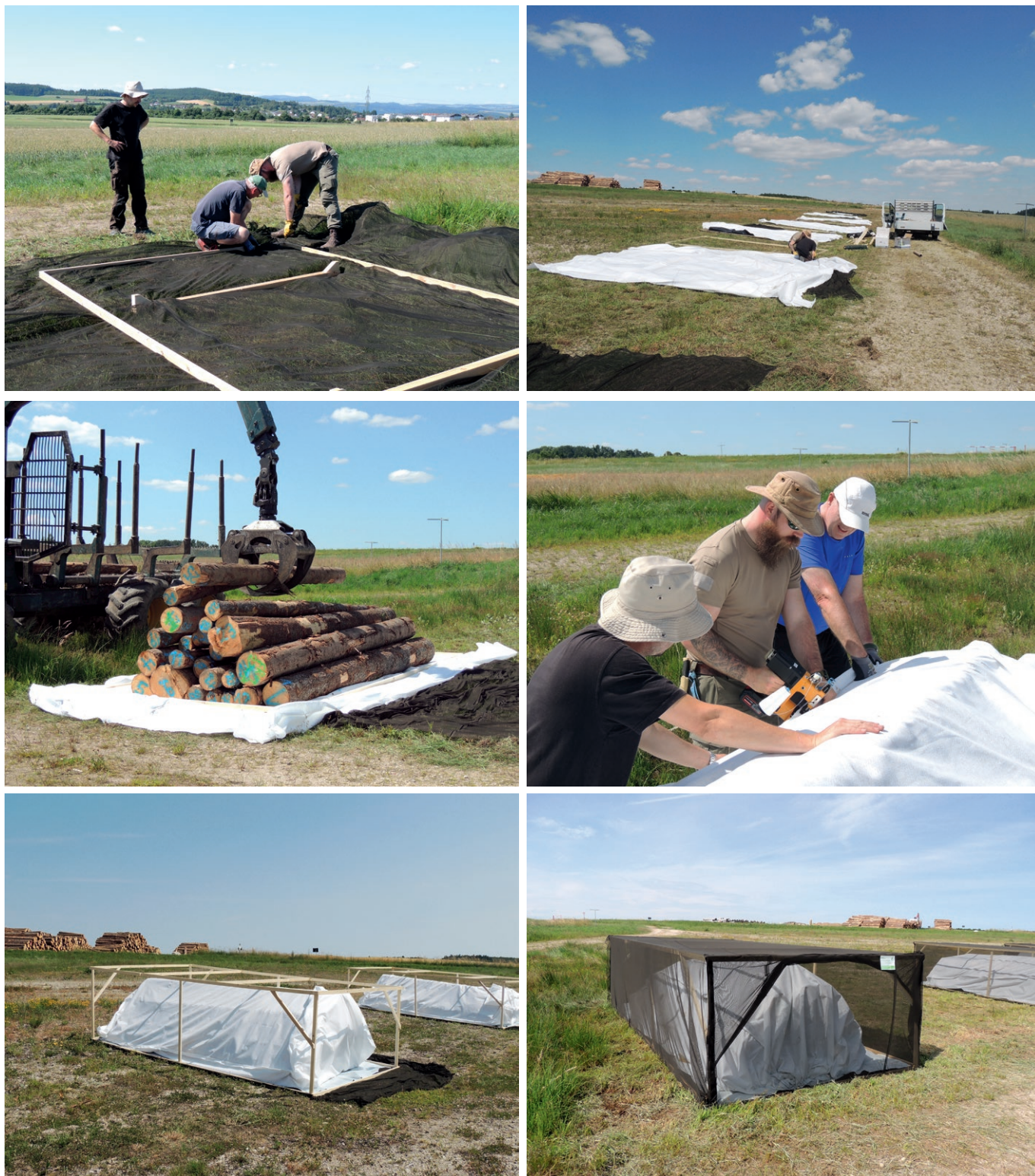
ABBILDUNG 1: Bau der Versuchspolter mit Vliesverpackung und Insektizidnetz-Käfig (Storanet®). Von links oben nach rechts unten: Storanet und Bodenrahmen des Käfigs, Auslegen der Vliesbahnen, Bau der Polter mit den Versuchsblochen, Vernähen der Vliesverpackung, Aufbau der Storanet-Käfige, fertiger Versuchspolter.
